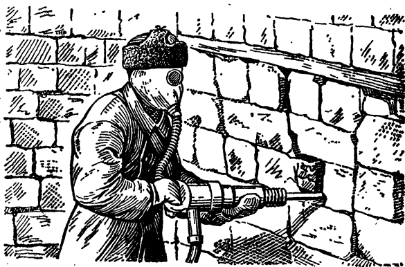
Рис. 36. Пробивание отверстия в стене убежища
